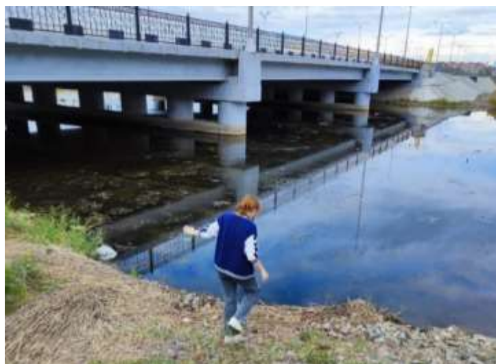
Рис. 3 Мост через реку Кылшакты.
